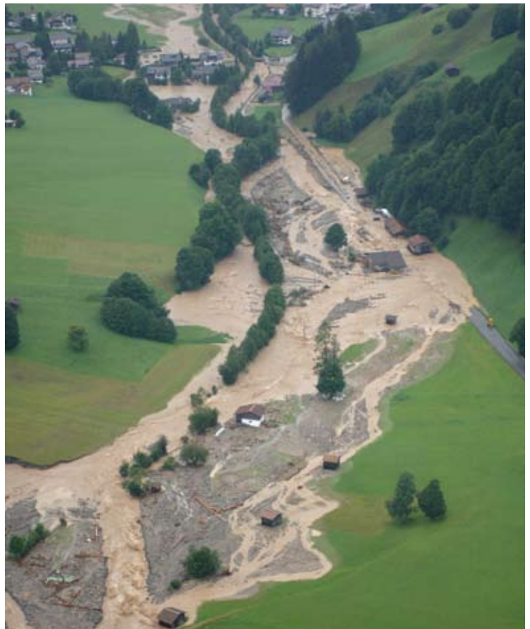
Grossflächige Überschwemmungen in Klosters im August 2005 mit ausserordentlichen Erosionen und Geschiebeverfrachtungen, Foto: Chr. Wilhelm, AfW.
