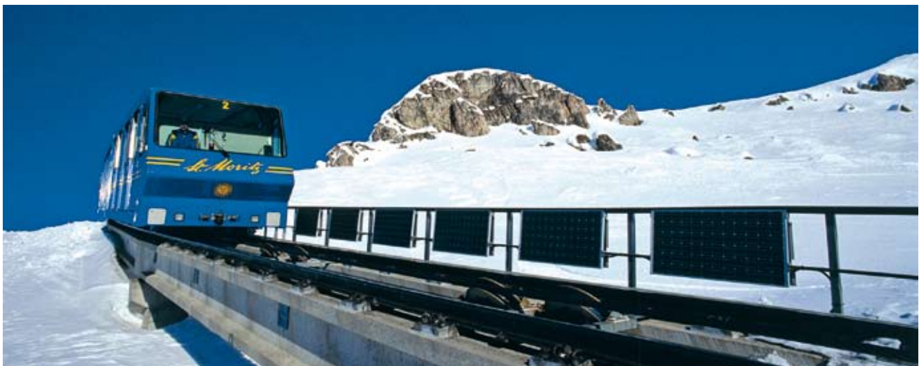
Solare Photovoltaik-Anlage Corvigliabahn (18 kWp). Weitere Photovoltaik-Anlagen befinden sich bei den Berg- und Talstationen der Piz Nair Bahn, Foto: Clean Energy St.Moritz.
