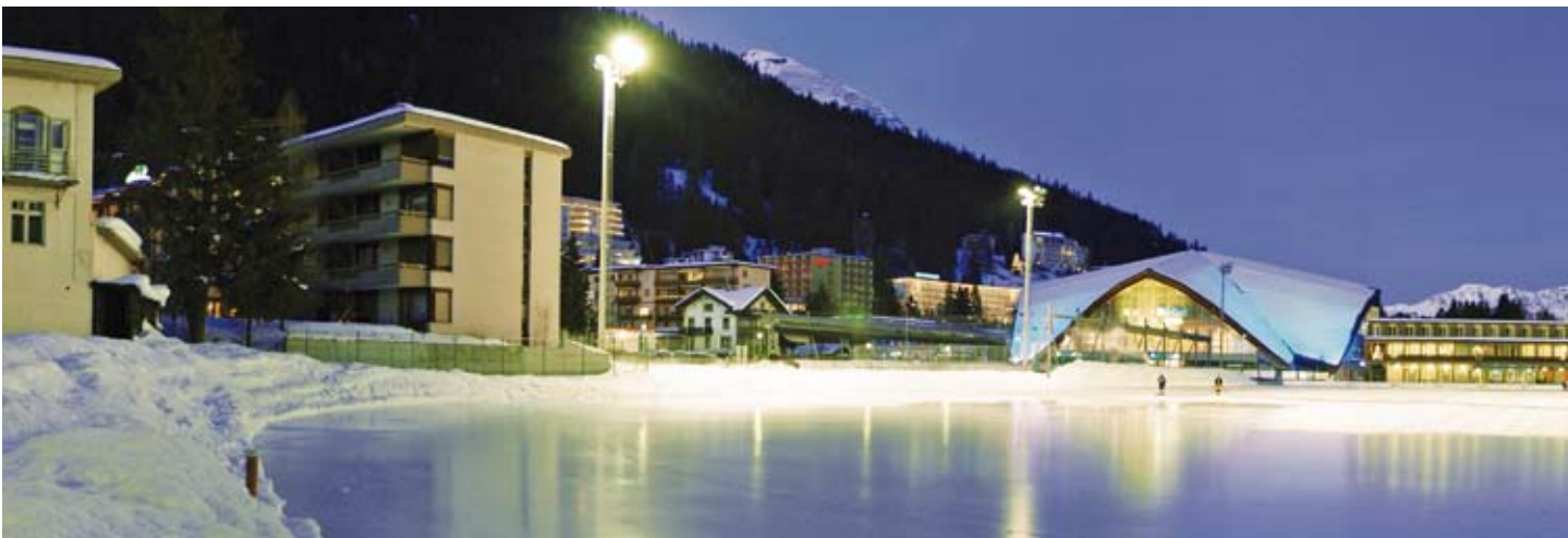
„Energiesiegel“ Davos: Gütesiegel mit Zukunft. Seit November 2008 wird die Abwärme der Kälteerzeugungsmaschinen der offenen Kunsteisbahn aufbereitet und über eine Fernwärmeleitung ins Hallenbad geleitet. Dadurch werden jährlich rund 350 Tonnen weniger CO 2 ausgestossen, Foto EWD (D.Schneider, C. Nett).
