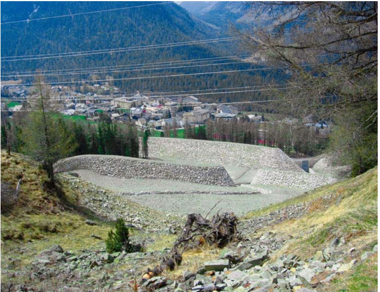
Schutzdämme gegen Murgänge und Lawinen oberhalb von Pontresina, Foto Chr. Wilhelm.
