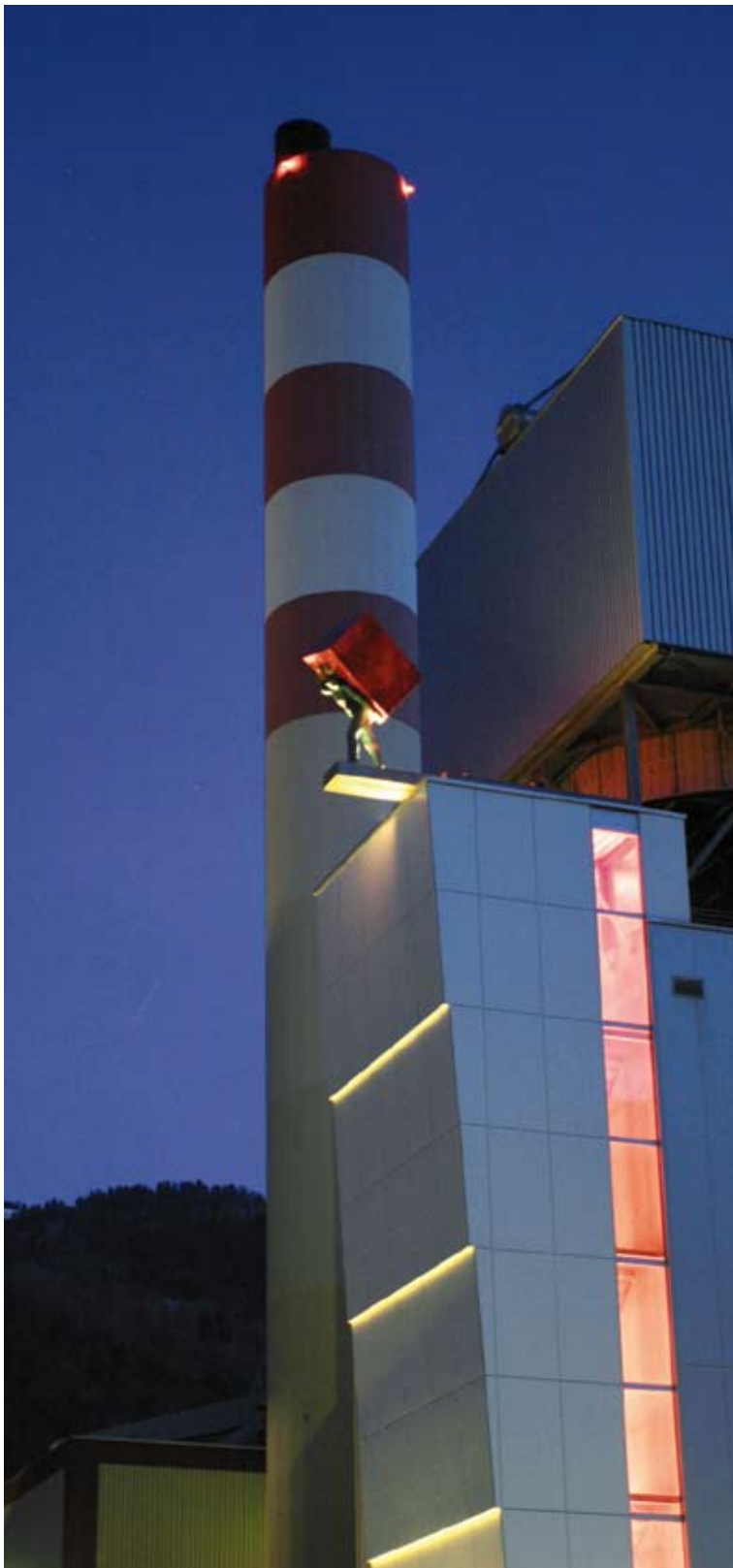
In der Kehrichtverbrennungsanlage (KVA) in Trimmis wird thermische und elektrische Energie produziert. Ein Teil davon wird an die Papierfabrik LandQart und an öffentliche Bauten in der Gemeinde Igis geliefert, Foto Indermaur-Kunst bei der KVA.
